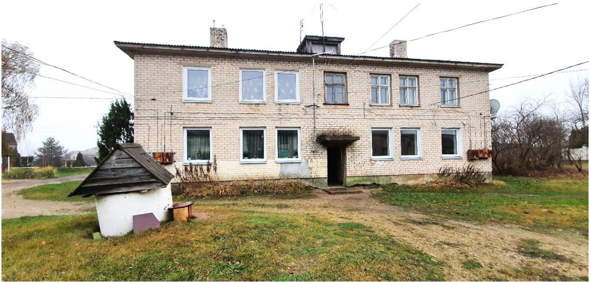
1pav. Šiaurės vakarų fasadas.
